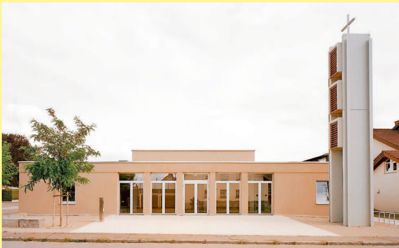
Foto: Vécsey Schmidt Architekten
