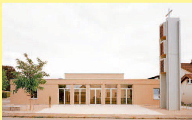
Foto: Vécsey Schmidt Architekten
